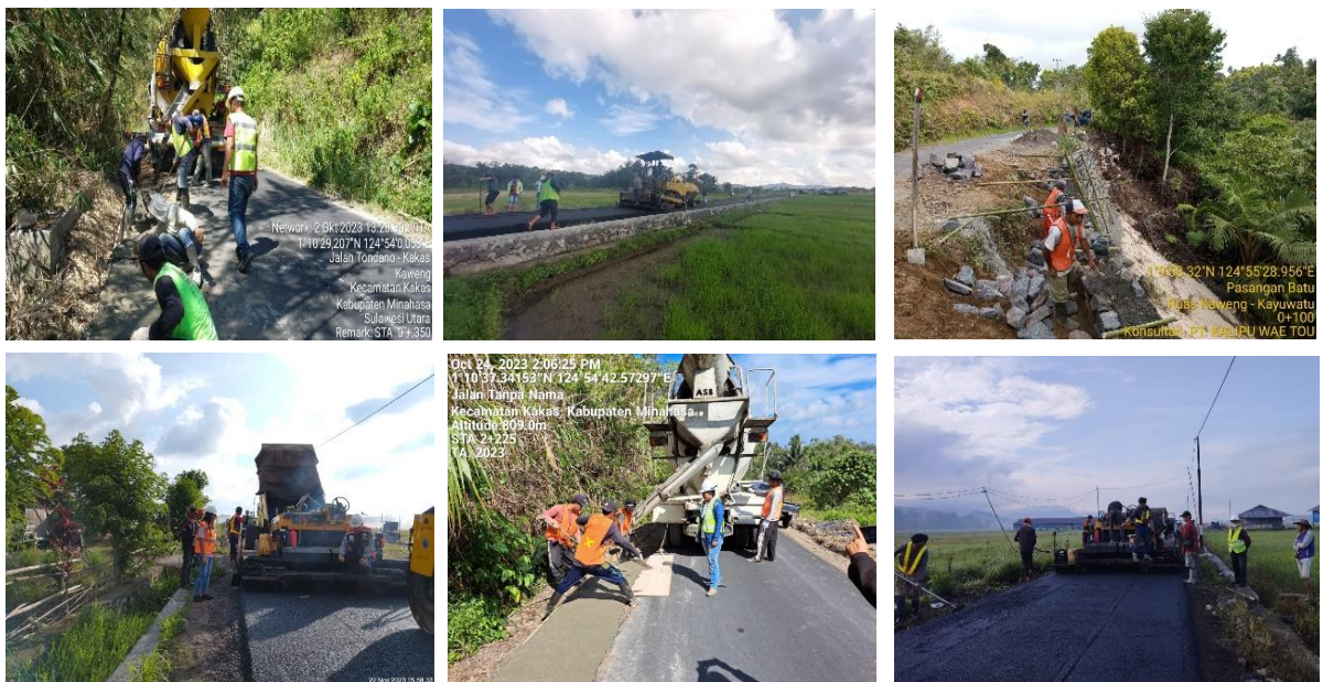
Foto 1 Kegiatan Penyelenggaraan Jalan Kabupaten Minahasa Tahun 2023
